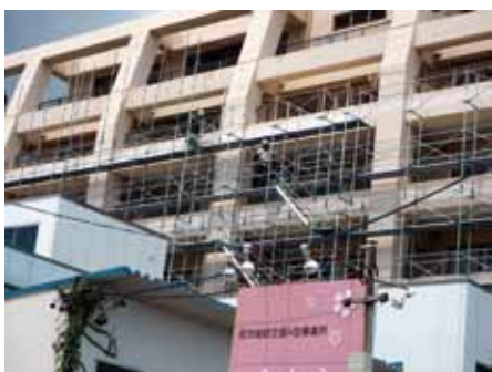
■ ガーデニアガーデン南安倍改修工事 (ダーウィン足場施工風景)
