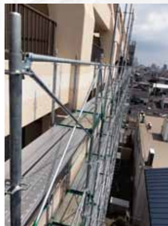
■ 県営松富団地外壁調査工事 (ダーウィン足場)
