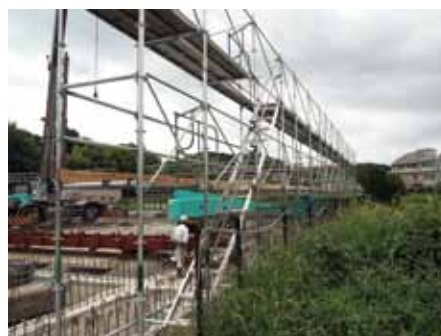
■ 掛川市丸山ホールディングス新築工事 (ダーウィン足場)
