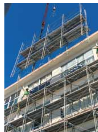
■ 静岡市立長田西中学校改修工事 (大払し解体風景)
