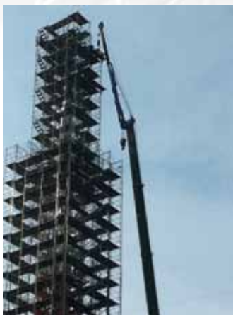
■ 静岡国道事務所無線塔改修工事 (杵組本足場)
