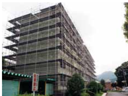
■ 県営松富団地外壁調査工事 (ダーウィン足場)
