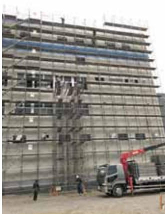
■ 新静岡鈴与物流センター新築工事 (杵組本足場)
