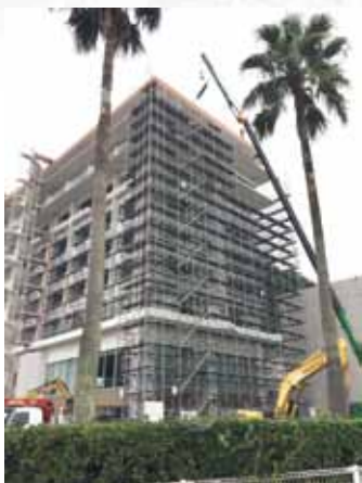
■ 熱海後樂園ホテル解体工事 (杵組本足場)
